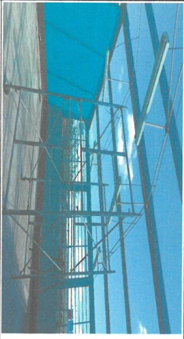
Foto 1: Ya se retiró el techo de lámina para instalar el nuevo techo de lámina troquelada calibre 26 de aluzinc.
