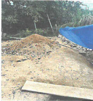
FOTO 1: Espacio en donde se realiza el pozo de absorción.
