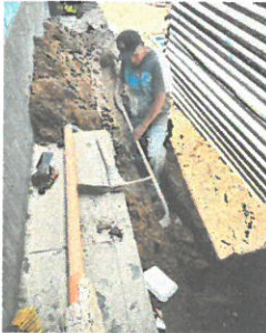
Foto 5: Reparación de salida de fosa séptica.
