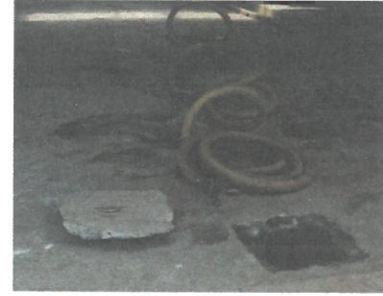
FOTO 2: Limpieza de fosa séptica.
