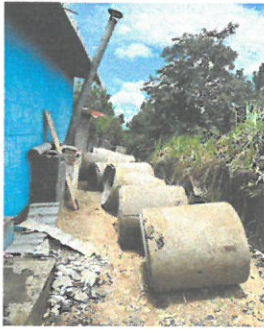
FOTO 3: Inicio de reparación de chimenea.
