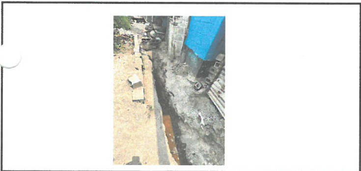
Foto 5: Salida de la fosa séptica, se llena muy rápido y se debe limpiar cada tres meses al no hacerlo provoca malos olores y deja sin funcionamiento los servicios sanitarios.
