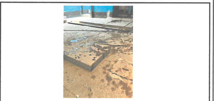
Foto 6: En el patio de la escuela se encuentra la fosa séptica, se observa una tapadera con un nylon porque por allí se filtran los olores de la fosa creando insalubridad en la escuela.
