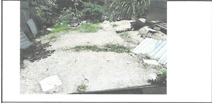
FOTO 1: Espacio para la construcción de pozo de absorción.
