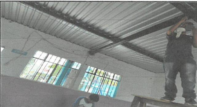
En esta imagen se muestra la instalación de cajas octogonales donde se atornillara las nuevas plafoneras.
