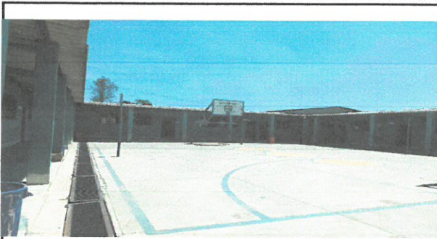
Esta es la vista de la parte interior de la escuela
