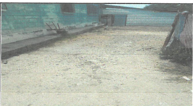
vista a lo ancho del patio a pavimentar
