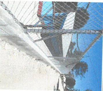
Foto 2: Vista de finalización de trabajo, cambio de techo de bodega, con láminas troqueladas y estructuras de costaneras metálicas.
