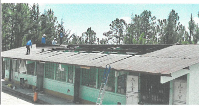
Quitada de techo de la escuela
