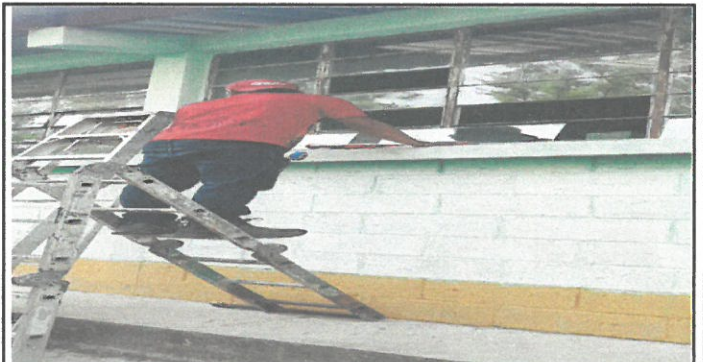
Colocación y pegado de vidrios de las ventanas
