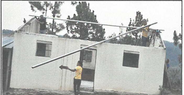
Colocación de tubos galvanizados y entechado de la cocina
