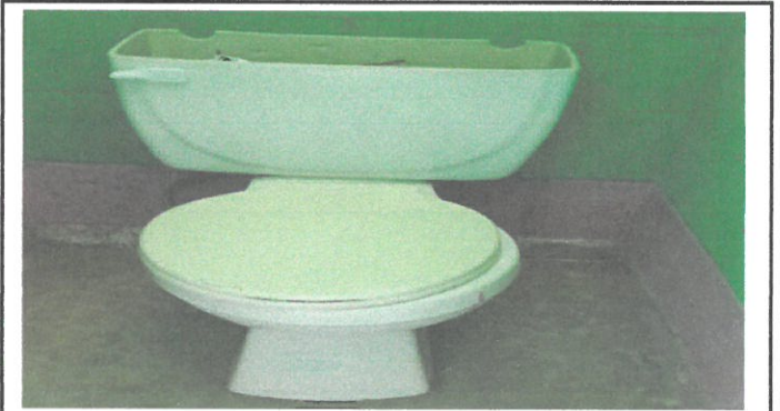
Vista de baños de niñas a remozar
