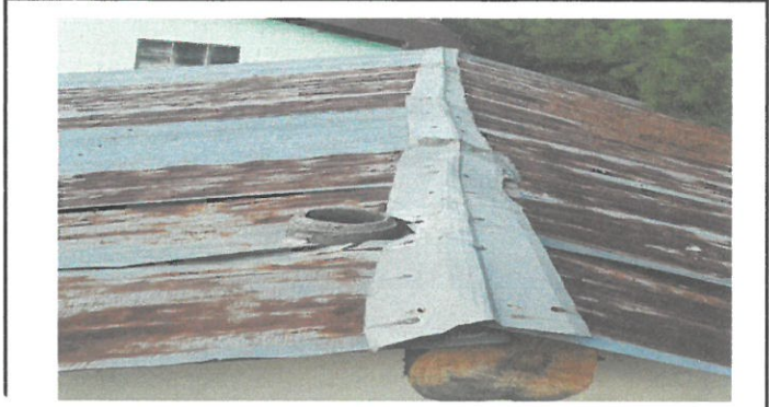
Vista de techo de cocina a remozar
