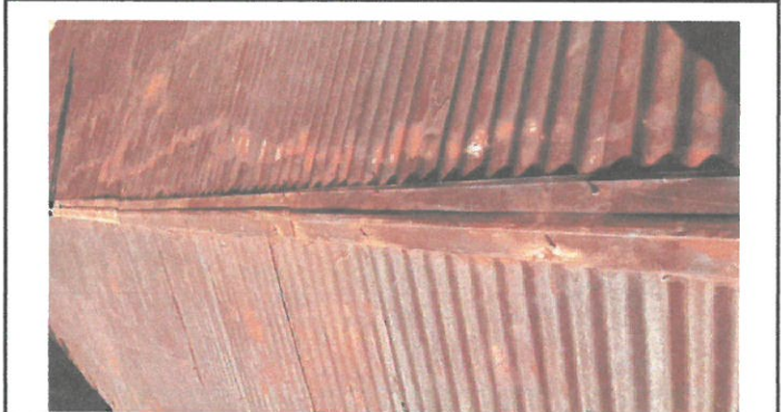
Vista de techo escuela a remozar
