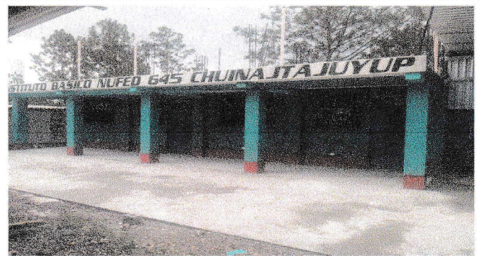
Foto 4: Mejoramiento de Patio
