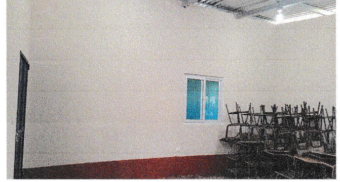
Foto 2: Remozamiento de aula, ampliacion de muro de 10 hileras de block
