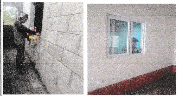
Foto 8: Levantamiento y colocación de ventana.
