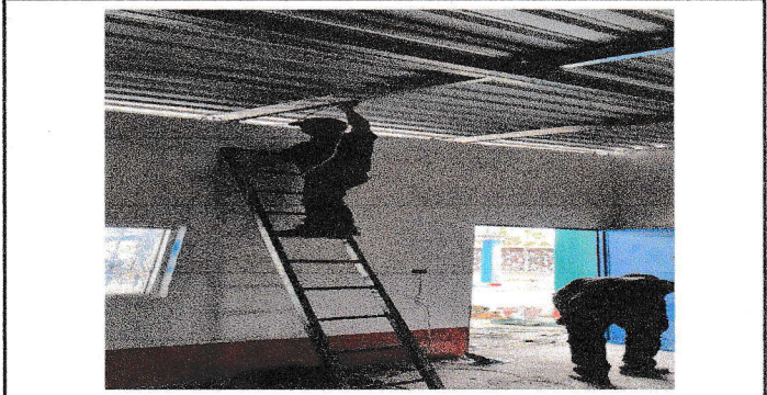
Foto 10: Sustrucción de cables, tomacorrientes y apagadores de tres aulas.
