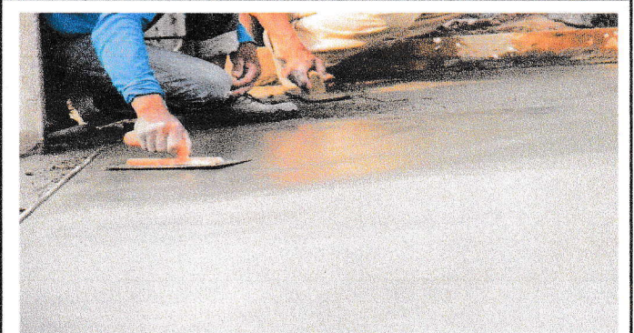
Foto 4: Mejoramiento de Patio
