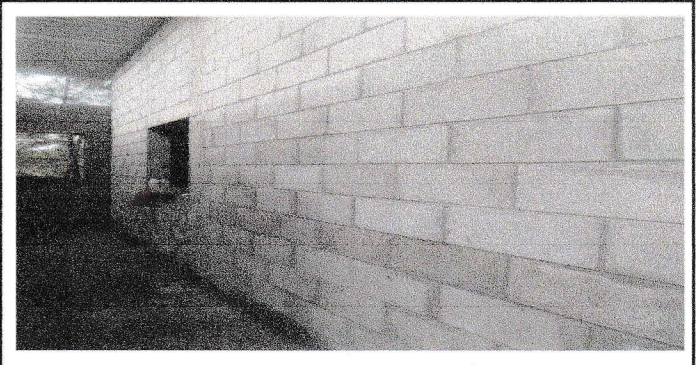
Foto 2: Remozamiento de aula, ampliacion de muro de 10 hileras de block
