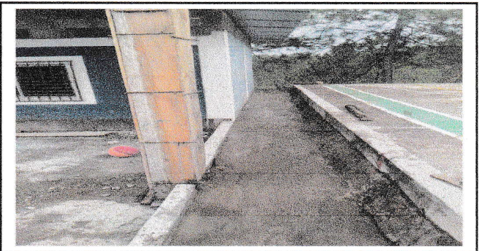
Foto 6: Mejoramiento de cuneta.
