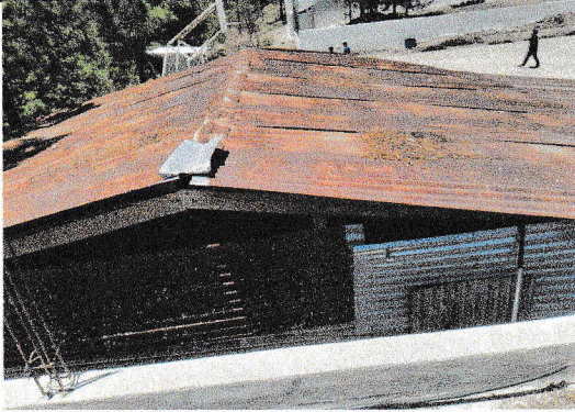
Foto 1: Sustitución de techo
