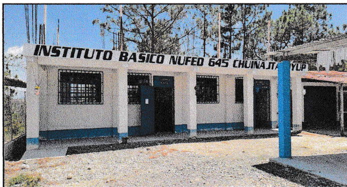
Foto 5: Pintura de paredes interiores y exteriores de tres aulas.
