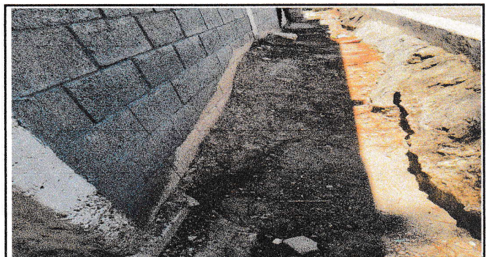
Foto 6: Mejoramiento de cuneta.
