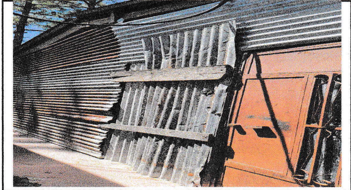
Foto 8: Levantamiento y colocacion de ventana.
