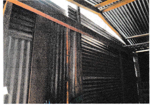
Foto 2: Remozamiento de aula, ampliación de muro de 10 hileras de block
