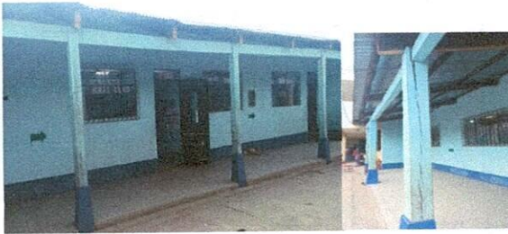
SUSTITUCION DE PILARES DE MADERA POR CONCRETO EN CORREDOR
