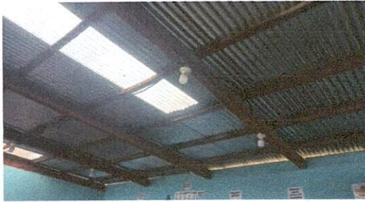
NIVELACION DE TECHO Y SOLERA DE CORONA BAJO CUBIERTA EN AULA 1 Y 2
