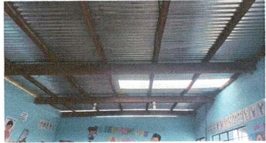
ESTRUCTURA DE TECHO EN AULA 1 Y 2 POR COSTANERAS DE METAL
