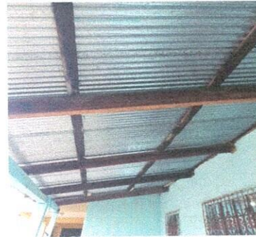
SUSTITUCION DE VIGAS DE MADERA POR CONCRETO CORREDOR DE ESCUELA
