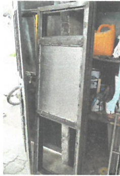
Proceso de fabricación de puertas de metal que sustituirán puertas en baños
