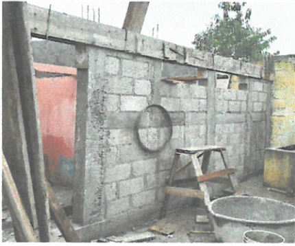
Proceso de levantamiento de muro perimetral para cepear baños de patio
