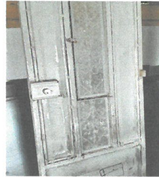
Proceso de pintado de puertas de bodega y cocina
