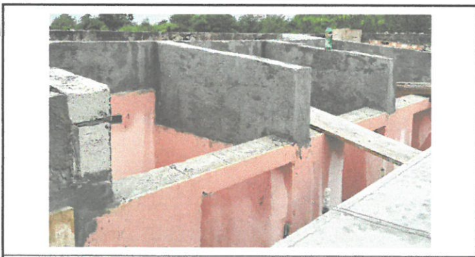
Proceso de elevación y nivelación de paredes de baños.
