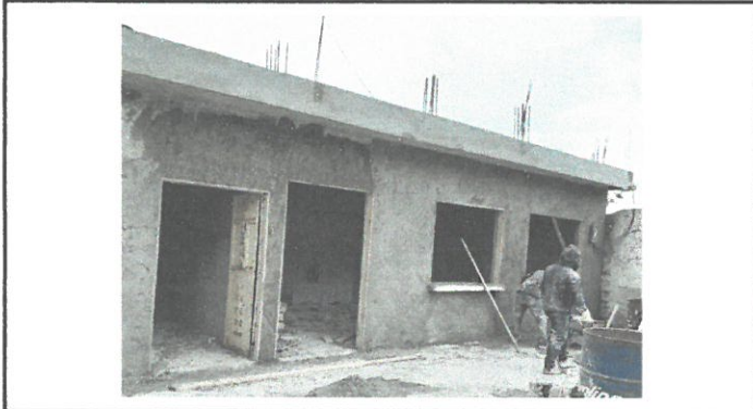
Vista frontal del proceso de repello y cernido de la cocina y bodega.
