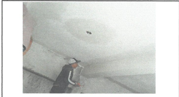
Vista interior de la cocina en el proceso de repello y cernido
