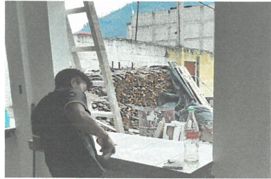
Proceso de preparación de espacio para la instalación de ventanas en UPVC
