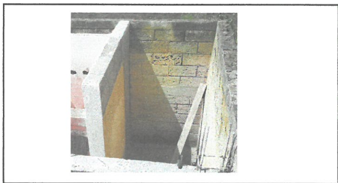
Vista de la pared que cierra espacio en baños.
