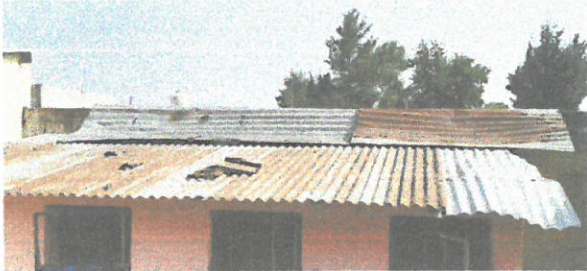
Vista frontal de módulo de baños a remozar con levantamiento de muro perimetral para separar baños de patio.
