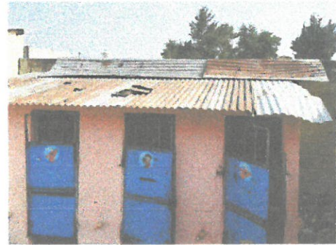
Vista del techo de baños a remozar con sustitución de láminas por láminas troqueladas.
