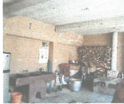
Vista interior de la cocina a remozar con repello y cernido.
