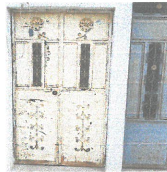
Vista de puertas de bodega y cocina a remozar con pintado
