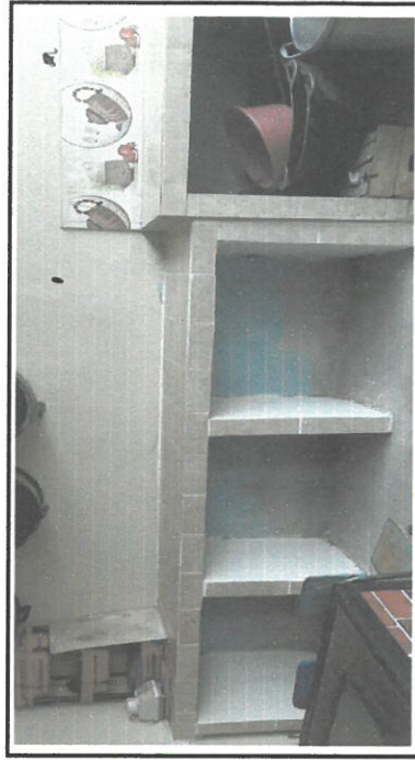
Vista de espacio para ampliación de mesas de concreto en cocina.
