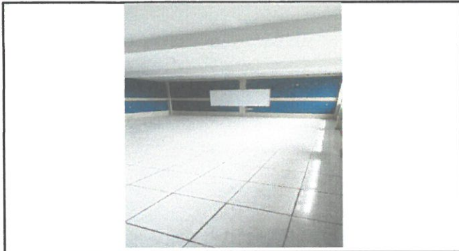
Foto 1: Primer piso módulo 2: instalación de piso y alisado de cielo
