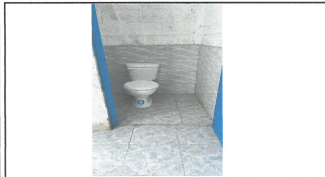
Foto 3: Baño de señoritas: instalación de azulejo en piso y paredes, lavamanos de concreto, reemplazo de inodoros, plomería completa.
