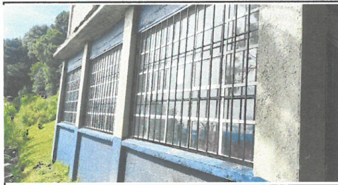
Foto 3: Primer piso módulo 2: Instalación de varandas de 4 ventanas y una puerta
