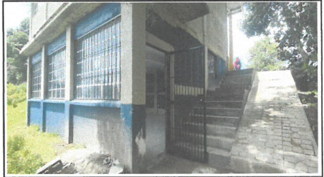
Foto 2: Primer piso módulo 2: Instalación de varandas de 4 ventanas y una puerta
