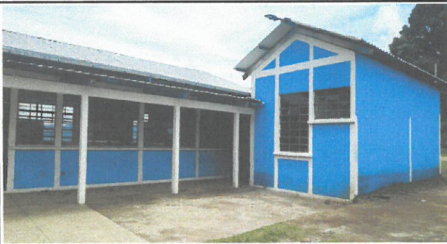
Foto 3: Pintura de módulo 1, vista exterior, torta de cemento en patio y puerta corrediza de metal.
