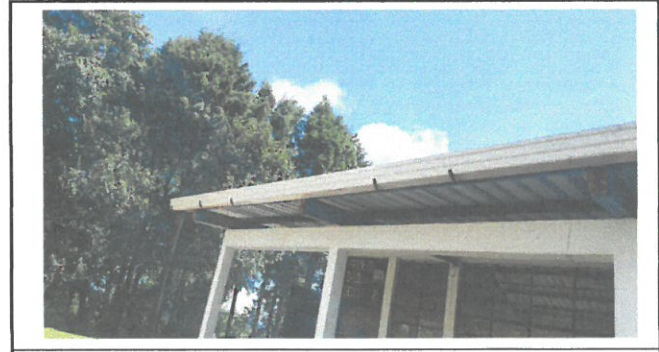
Foto 6: Colocación de canaletas en techo
