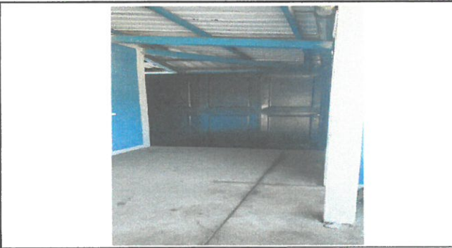
Foto 5: Colocación de puerta corrediza
