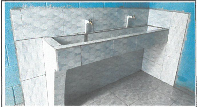
Foto 2: Baño de varones: instalación de azulejo en piso y paredes, lavamanos de concreto, reemplazo de inodoros, plomería completa.
