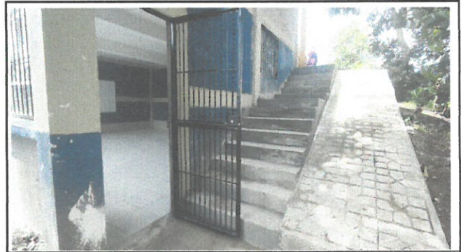
Foto 4: Primer piso módulo 2: Construcción de rampa y gradas de acceso
