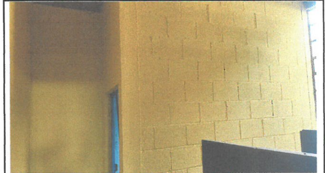
Foto 4: Pintura de módulo 1, vista interior
