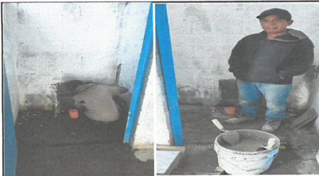
Foto 3: Baño de señoras: instalación de azulejo en piso y paredes, lavamanos de concreto, reemplazo de inodoros, plomería completa.
