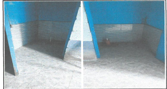
Foto 4: Baño de varones: instalación de azulejo en piso y paredes, lavamanos de concreto, reemplazo de inodoros, plomería completa.
