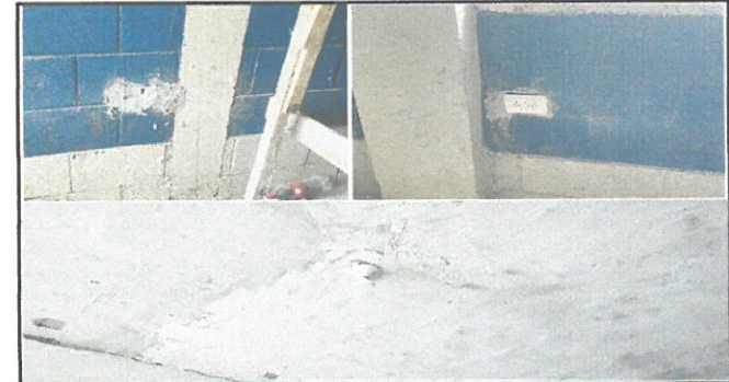
Foto 6: Instalación eléctrica en módulo 2. Primer piso (focos y tomacorrientes)
