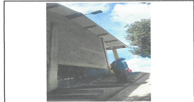
Foto 6: Instalación de lámparas solares módulo 2
