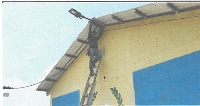
Foto 5: Instalación de lámparas solares módulo 1
