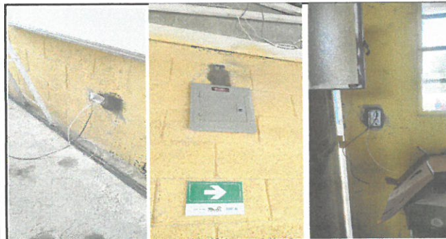
Foto 5: Instalación eléctrica en módulo 2. Segundo piso (focos y tomacorrientes)
