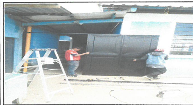
Foto 5: Colocación de puerta corrediza
