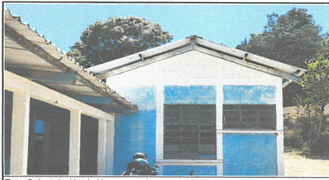
Foto 5: Instalación de lámparas solares módulo 1
