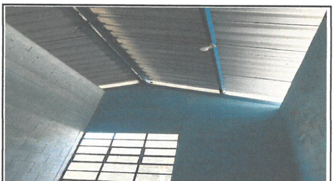
Foto 4: Pintura de módulo 1, vista interior
