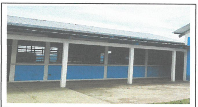
Foto 6: Colocación de canaletas en techo
