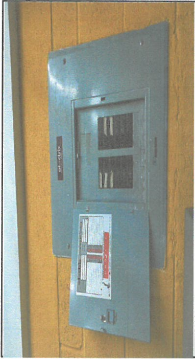
Foto 45: REPARACION O SUSTITUCION DE SISTEMA ELECTRICO
