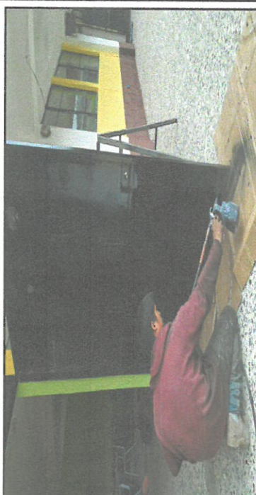
Foto 30: Reparación de Chapas y pintura de puertas
