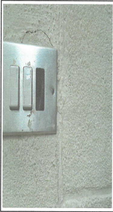
Foto 27: Reparación o sustitución del sistema eléctrico
