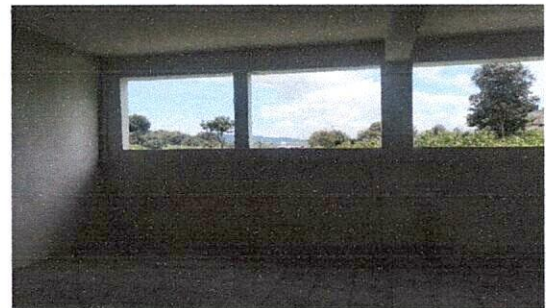
Instalación de ventanas
