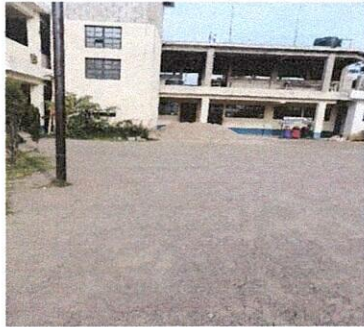
Cambio de piso de tierra por concreto
