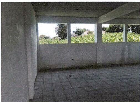
Instalación de Ventanas
