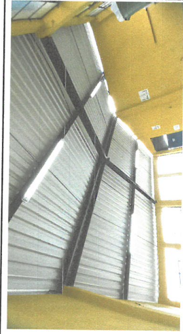
bombillas nuevas instaladas
