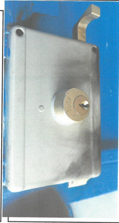
Foto 3: Sustitución de chapas de puertas de aula
