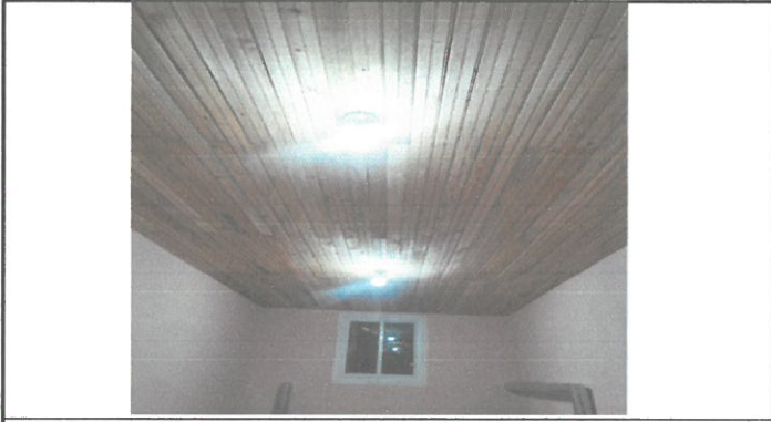
Foto 3: TECHO DE COCINA MACHIMBRADO Y MEJORADO.
