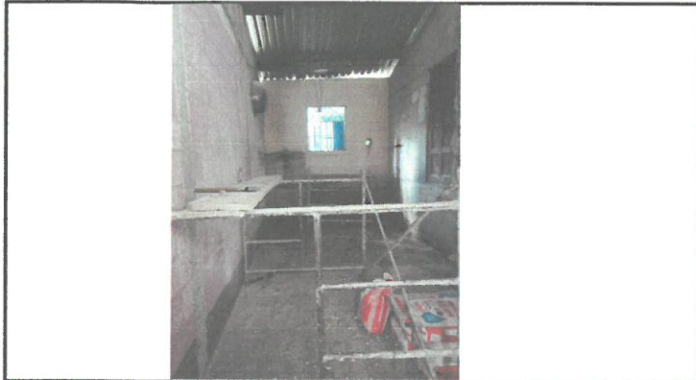
Foto 1: COCINA EN PROCESO DE REMOZAMIENTO.
