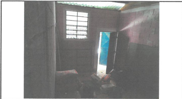
Foto 3: COCINA EN PROCESO DE AMPLIACIÓN Y REMOZAMIENTO.
