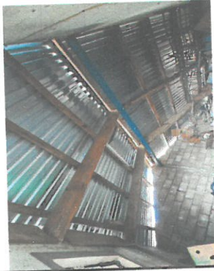
Foto 3: Suministro e instalación de portante de techo de aula.
