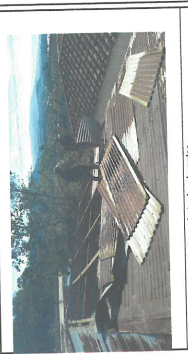
Foto 2: Cambio de láminas de techo de aulas.
