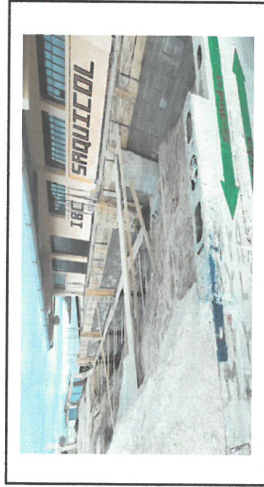
Foto 3: Aquí se coloca formaleta para fundir la solera final de la reparación del muro de contención frente a la cancha de basquet bol
