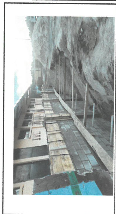
Foto 6: Se observa la fundición de la corona final y parte reynada del muro de contención frente a la cancha de basquet bol
