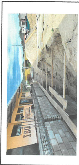
Foto 3: Aquí se coloca formaleta para fundir la solera final de la reparación del muro de contención frente a la cancha de basquet bol
