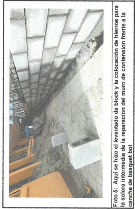
Foto 6: Levantado de block y colocación de formaleta para fundir solera intermedia de la reparación del muro de contención frente de la cancha de basquet bol.
