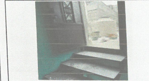
Instalación de puerta y de gradas metálicas
