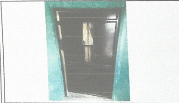
Restauración de puerta
