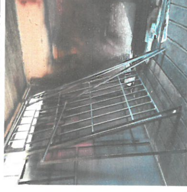
Foto 2: Intalacion de balcones
