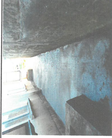
Foto 4: Reparación de cumeta
