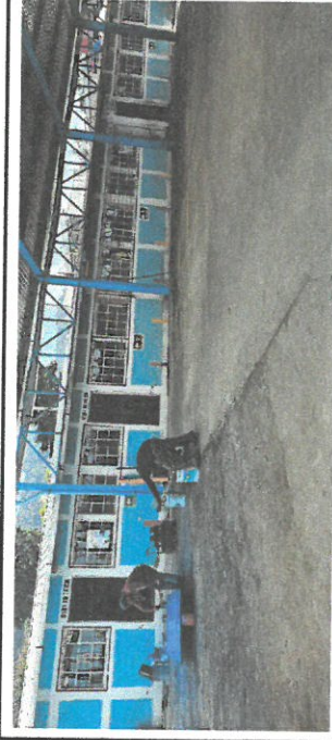
Foto 4: vista de parte de patio en frente de cocina, trabajando suelo natural cubierto con piedrin con piso de concreto
