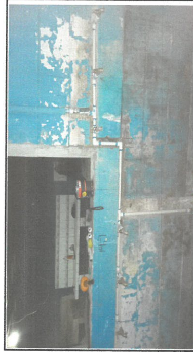
Foto 4: Sustitución de llaves de chorro.
