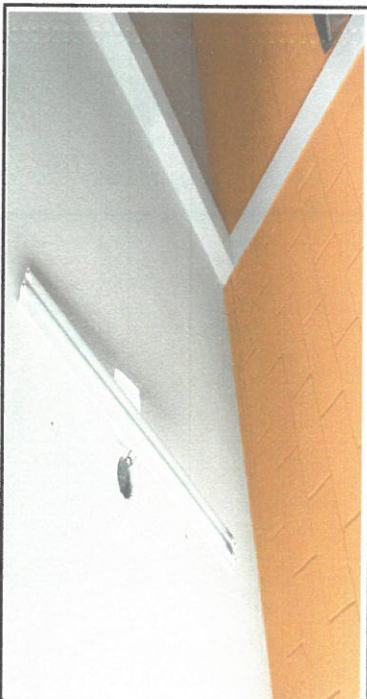
Foto 5: Reparación de lámparas.
