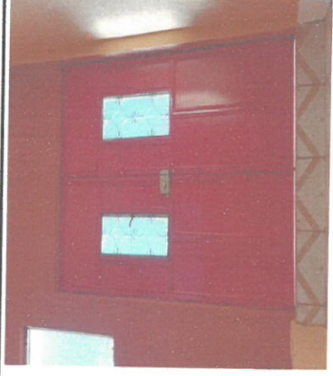
LA PUERTA DE LA SALIDA A LA TERRAZA FUE PINTADA Y LA CHAPA ES NUEVA
