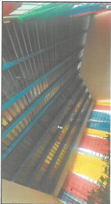
Foto 2: Sustitucion de alambres y lamparas
