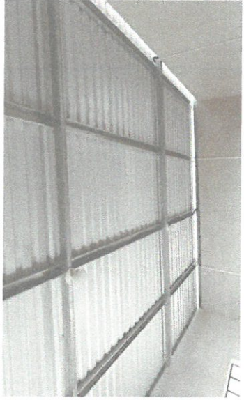
Foto1: Estructura de Techo, portante de lámina para cocina costaneras de 2X4 Pulgada
