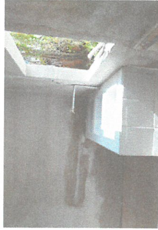
Foto 5: Construcción de lavapiatos de 2 alas forrado de azulejos
