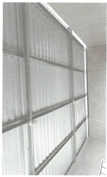
Foto 2: Suministro e instalación de lámina troquelada calibre 26 pulgadas
