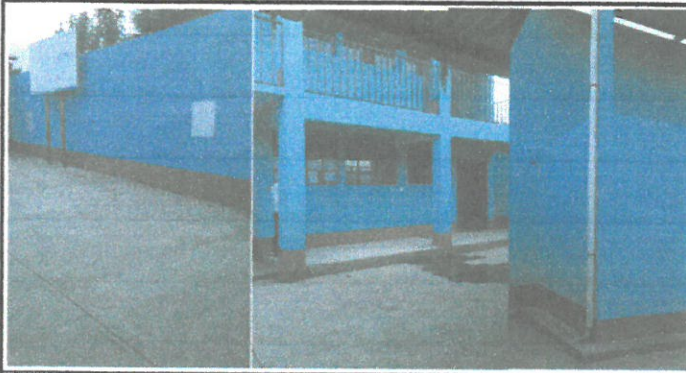
Paredes de aulas remozadas
