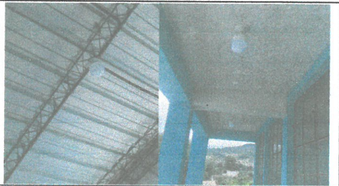
Sistema electrico ya remozado
