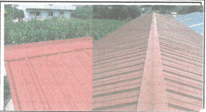
Techo exterior remozado
