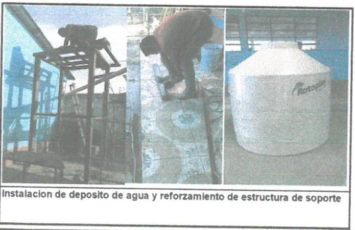
Instalacion de deposito de agua y reforzamiento de estructura de soporte
