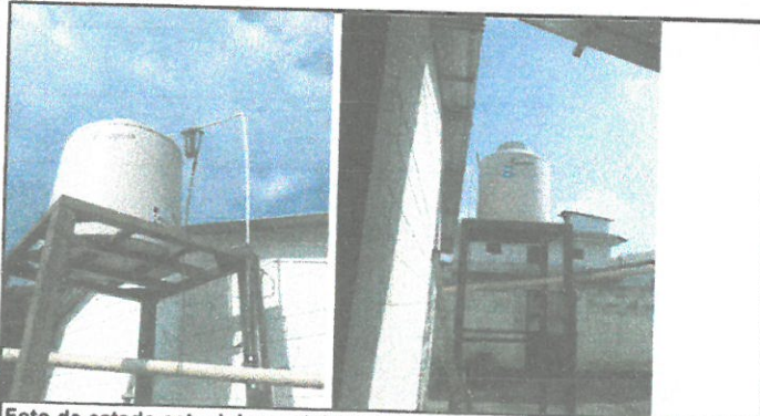
Foto de estado actual de suministro de agua
