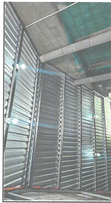
Foto 4: Vista de cambio de lámina
