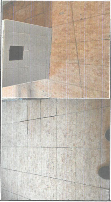
Foto 1: Instalación de piso area de cocina
