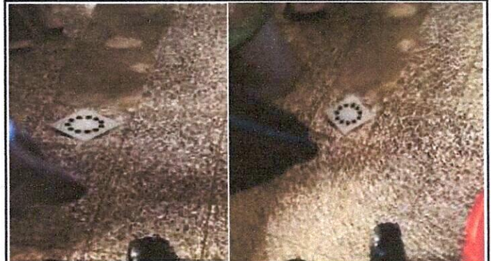
CAMBIO DE REPOSADERA EN EL AREA DE COCINA
