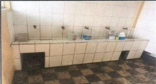
INSTALACION DE DRENAJE EN EL AREA DE NIÑOS E INSTALACION DE REPOSADERAS CON CONECCION A DRENAJE MAS CERCANO
