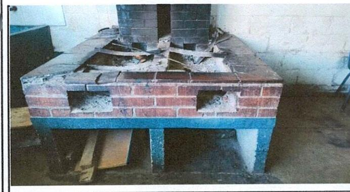
Colocación de azulejo al rededor de la plancha y colocación de parilla.
