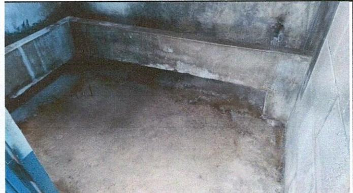
Foto 4: sustitución de torta de cemento por piso granito.
