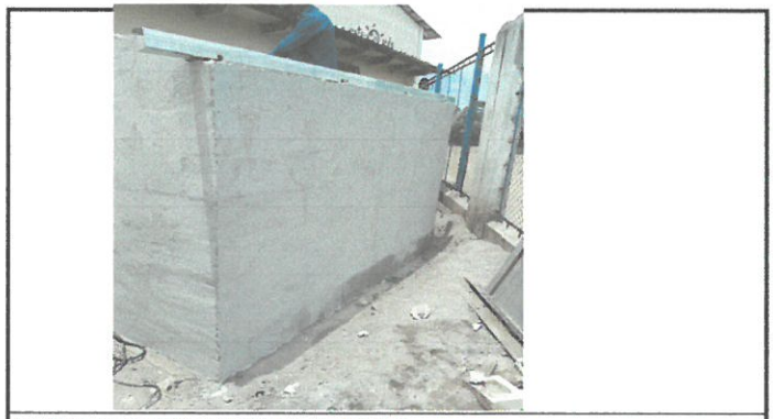
Cambio de techos a módulos de baños
