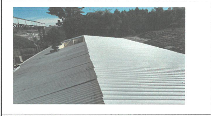
Cambio de techo de aulas
