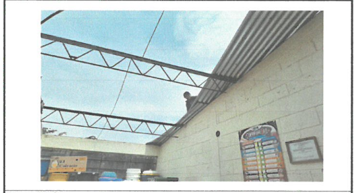
Fotos del área a remozar techo vista desde el interior
