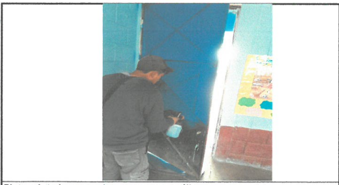
Pintura interior y exterior a puertas metálicas
