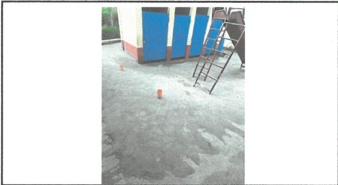
Área de pavimentación
