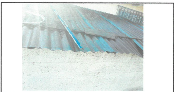
Cambio de techos a modulos de baños
