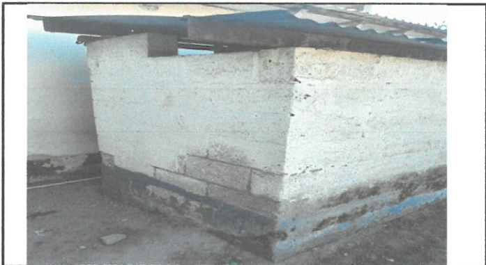
Foto de área de pavimentación y repello de pared servicios sanitarios
