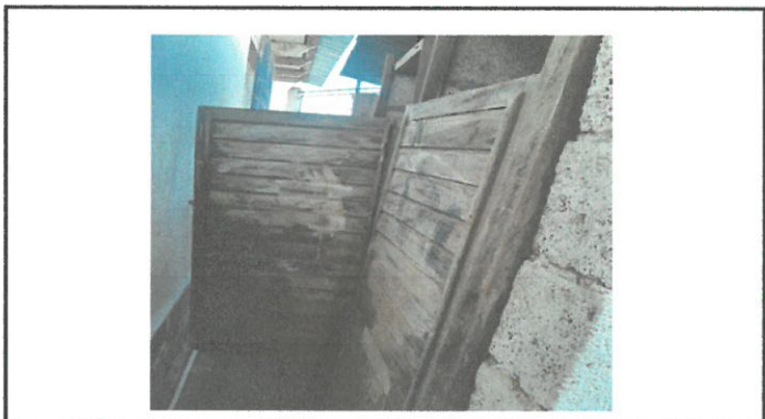
Puertas a cambiar, cambio de inodoros y construcción de mingitorio
