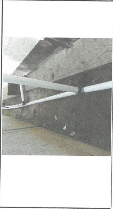
Foto 1: Sustitución de tubos de agua pluvial.
