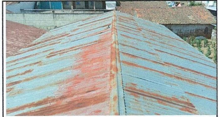
Foto 4: Sustitución de lámina, por lámina troquelada aluzinc calibre 26 y sustitución de capote de lámina para lámina troquelada.
