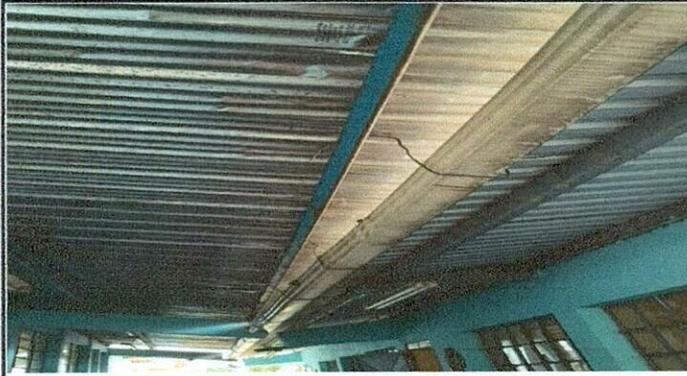
Foto 1: Sustitución de canal de metal
