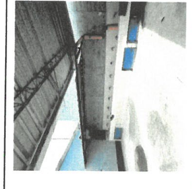
CUBIERTA DE LAMINA, Sustitución de lámina, por lámina troquelada aluzinc calibre 26. ESTRUCTURA DE TECHO, Sustitución de estructura de soporte de madera por metal.
