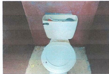
Foto 6: Sustitución de tazas y accesorios
