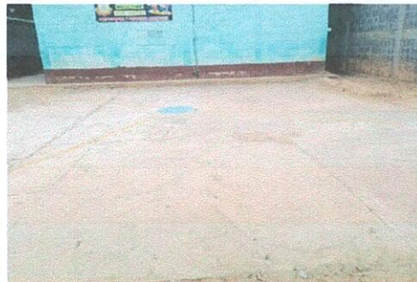
Foto 8: Sustitución de piso de torta de concreto
