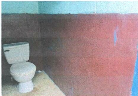
Foto 7: Instalación de azulejos en pared interior de baños
