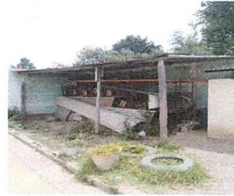
Sustitución de estructura de soporte de madera, por metal y lamina troquelada aluzinc calibre 26, bodega
