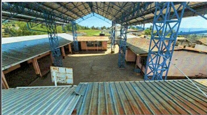
Foto 1: Sustitución de lámina troquelada Módulo Aula y Cocina
