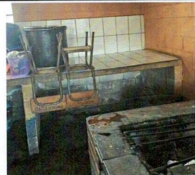
Foto 6: Sustitución deplancha rural completa
