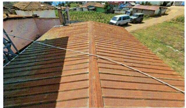
Foto 2: Sustitucion de lámina Modulo Aula
